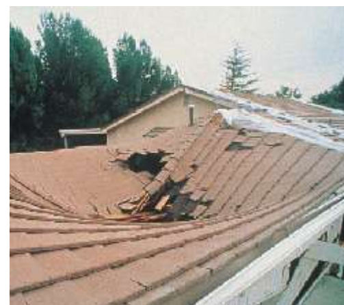
ЦЕМЕНТАНАЯ ЧЕРЕПИЦА СМЕСТИЛАСЬ, ЧЕМ ВЫЗВАЛА ПОВРЕЖДЕНИЕ СТРУКТУРЫ ДОМА
