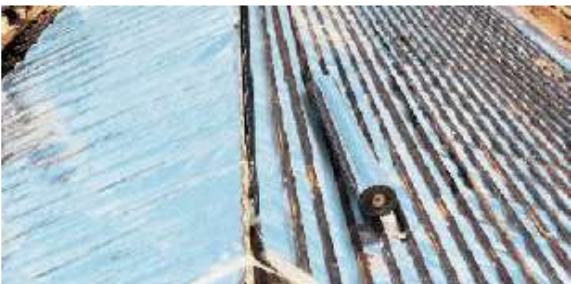
ФОЛЬГА ANI ROOFING УЛОЖЕНА НА ОБРЕШЕТКУ
