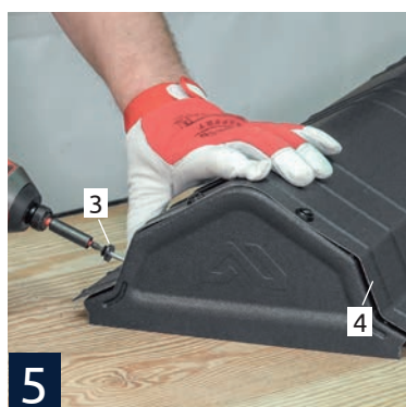
5 После сверления прикрепите торцевые элементы к коньку с помощью очередных двух винтов [3], [4] или заклепок в том же покрытии, что и основные элементы.
