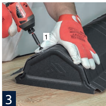
3 После сверления прикрепите торцевые элементы к коньку с помощью фермерских винтов [1], [2] или заклепок с покрытием.
