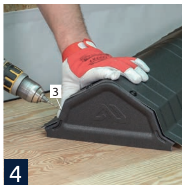
4 Затем просверлите еще 2 отверстия [3], [4] на боковых краях.
