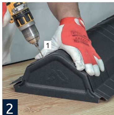
2 После установки, просверлите 2 отверстия в коньке [1], [2] на верхнем крае.
