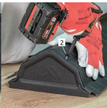
3 После сверления прикрепите торцевые элементы к коньку с помощью фермерских винтов [1], [2] или заклепок с покрытием.
