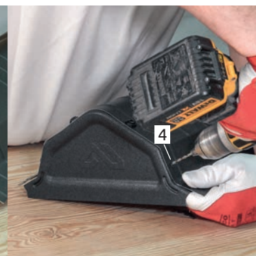
4 Затем просверлите еще 2 отверстия [3], [4] на боковых краях.
